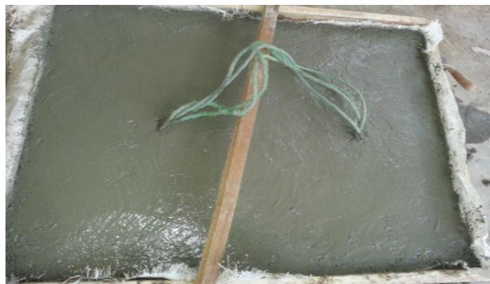
Gambar 2. Matras beton bendrat yang baru dicetak
