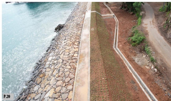
Gambar 1. Revetment Batu Pecah di Pantai Muli.
