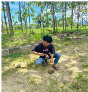
Gambar 3.13 Penanaman Elektroda Pembeduan
