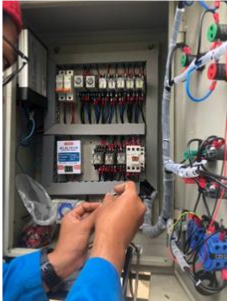
Gambar 11. Pengujian Kontinuitas Kabel.
