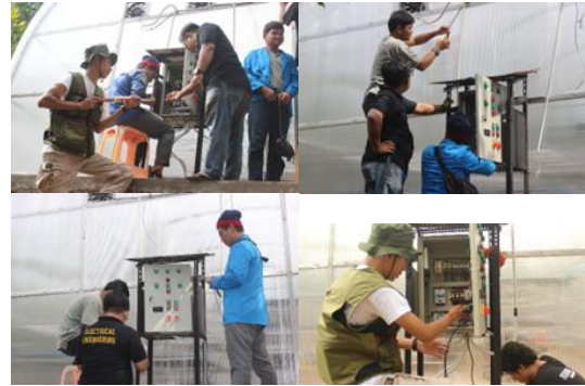
Gambar 13. Pemasangan Panel.
