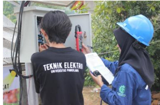
Gambar 19. Pengujian Arus Keluaran.
