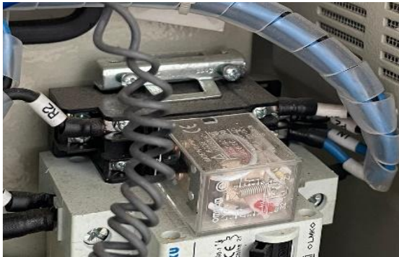
Gambar 5. Relay Pada Box APP
