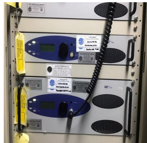
Gambar 6 Pengecekan indikator Radio VHF ER
