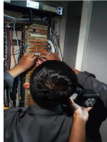
Gambar 9 Test Speaker dari MDF menuju Perangkat Lintas Arta (VSAT)
