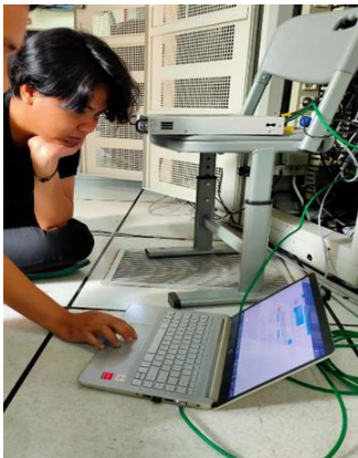
Gambar 12 Pengecekan jalur VCCS VHF ER menuju VSAT
