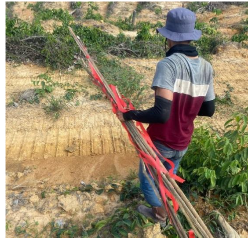
Gambar 2 Pemasangan tanda stake out boundary dan batas izin usaha
