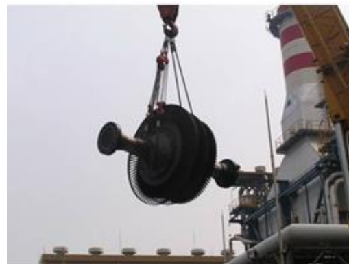
Gambar 8. Rotor turbin harus diangkat untuk membongkar sudu tetap di lower casing
