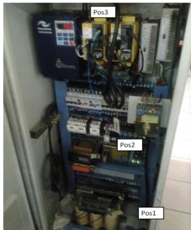
Gambar 8. Panel mesin bubut CNC CKE6130i
