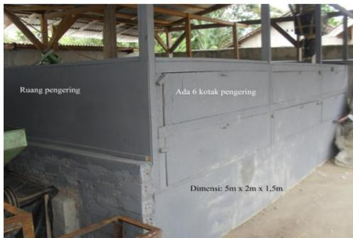
Gambar 3. Konstruksi ruangan pengeringan dengan kapasitas 400 kg
