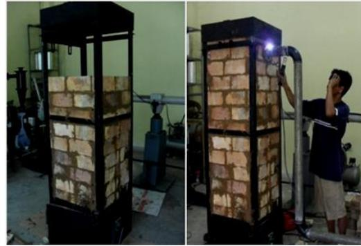
Gambar 7 .Pemasangan bata tahan api pada reaktor gasifikasi dengan semen tahan api dan sodium silikat sebagai pengikat
