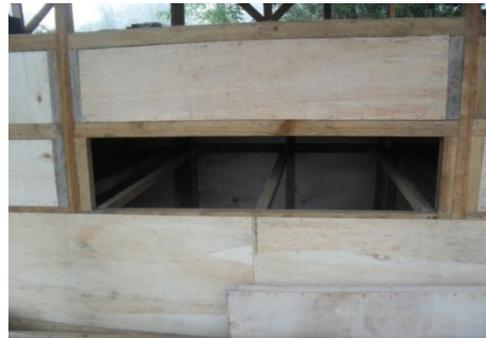
Gambar 5. Konstruksi dalam ruang pengering dan rak pengeringan
