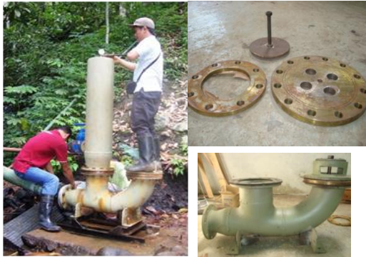
Gambar 1. Perakitan pompa hydam
