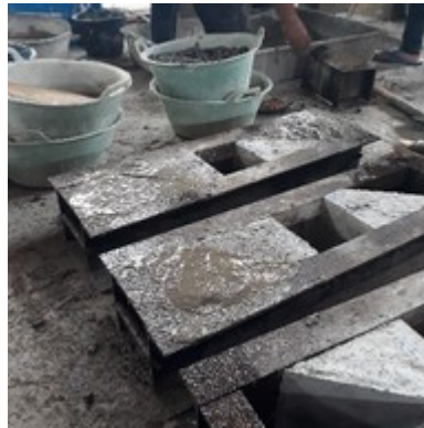
Gambar 4. Proses pengecoran beton baru ( overlay ).
