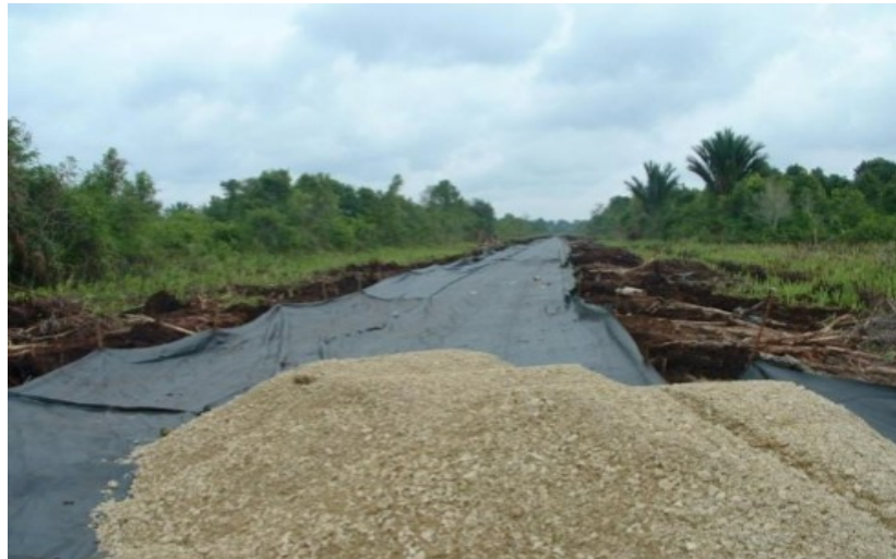
Gambar 10. Penerapan Geotekstil Woven (anyaman) (Sumber : Geosintetik-Indonesia.com)
