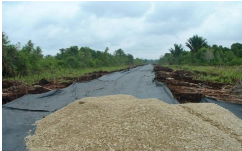
Gambar 10. Penerapan Geotekstil Woven (anyaman) (Sumber : Geosintetik-Indonesia.com)
