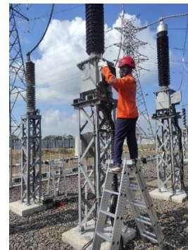
Gambar 3. Pengujian tahanan isolasi
