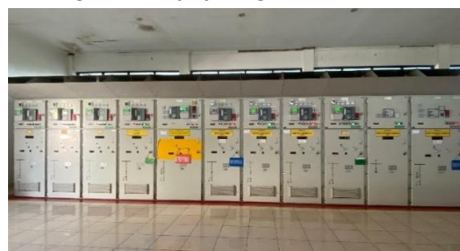
Gambar 2. Kubikel Tegangan Menengah GI Paniki
