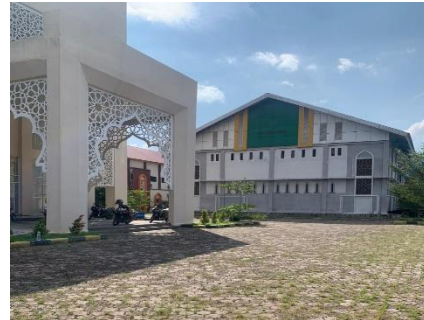
Gambar 2. Lokasi Instalasi Panel Surya
